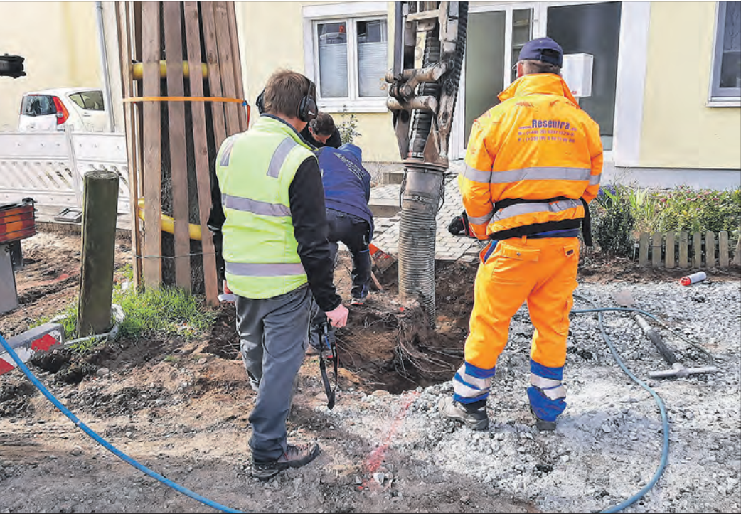
IN DER DONAUSTRASSE kommen aktuell sogenannte Saugbagger zum Einsatz. (Foto: Stadt Griesheim)
