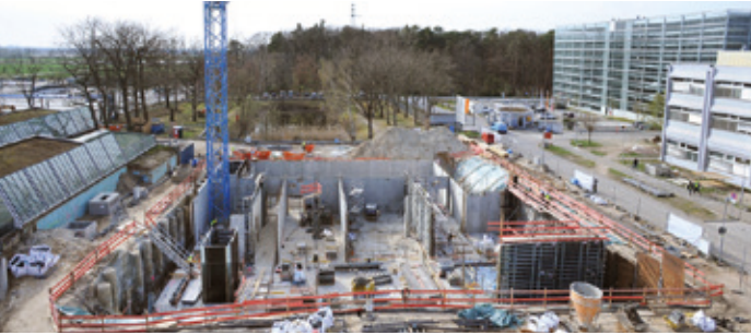
Blick auf die Baustelle, wo das neue FAIR Control Center entsteht.
