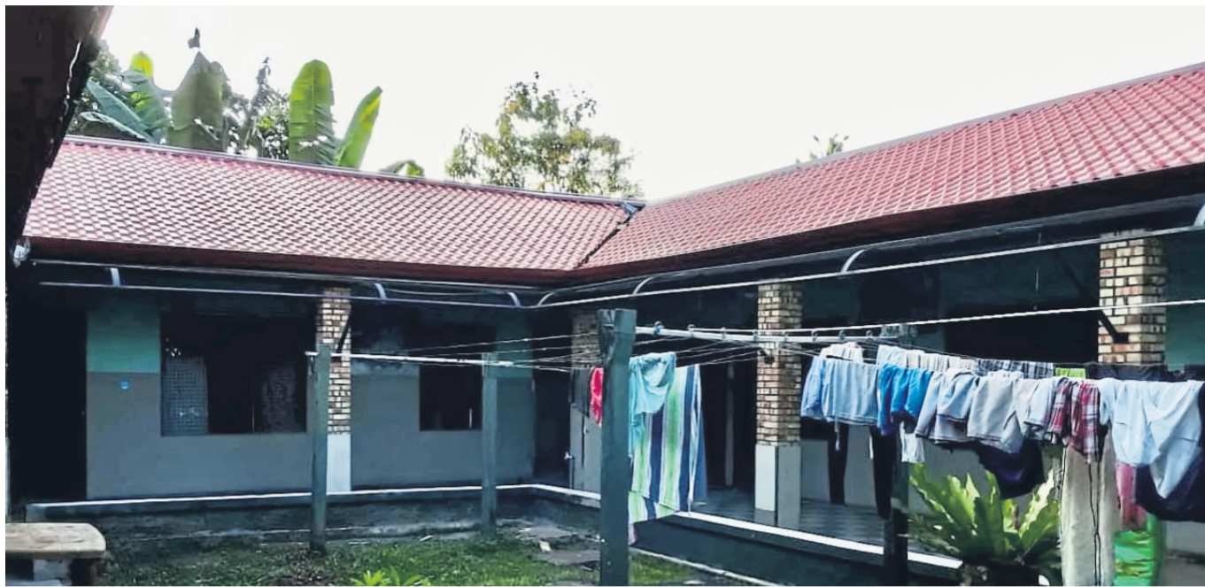
Unser Bild zeigt das Waisenhaus „Mama und Papa“, das dank der Hilfe aus dem Kreis ein neues Dach bekommen hat. Nun regnet es nicht mehr in die Schlafräume. Foto: privat
