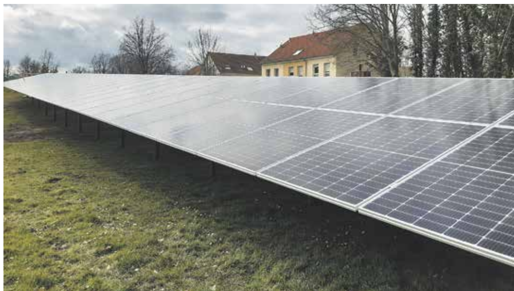
Die neue Photovoltaik-Anlage im Freibad Goddelau.
