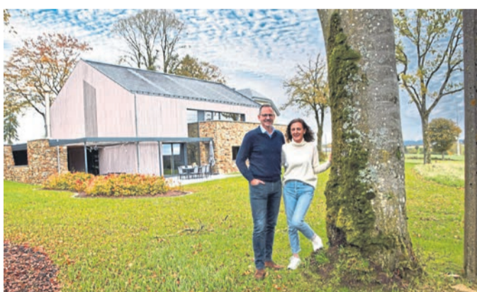
240 integrierte Solarpaneele im nachhaltigen Rathscheck Schiefer-System erzeugen auf dem Ferienanwesen in den Eifel-Ardennen bis zu 12 kW Strom – genug, um das Ensemble von Christianne und Philippe Heck im ehemaligen Geisterdorf Stefanshof nahezu unabhängig zu versorgen. Fotos: Rathscheck
