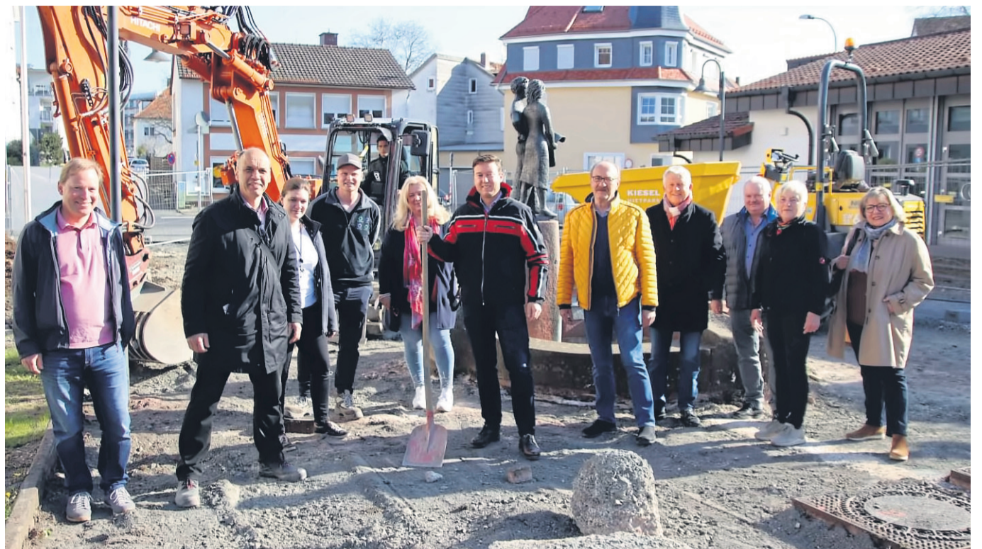
Bürgermeister Matthias Möller (Bildmitte) beim offiziellen ersten Spatenstich zusammen mit Vertretern von Verwaltung, Kommunalpolitik und der ausführenden Firma.
