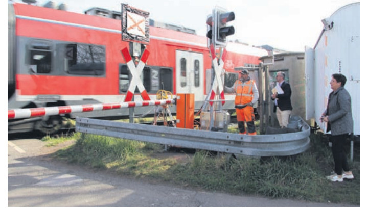
Am 16. Mai soll mit der Erneuerung des Bahnübergangs begonnen werden. (Foto: Stadt Rödermark)
