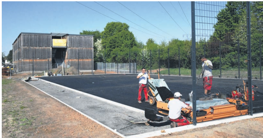
Der Bau des neuen Bolzplatzes an der Aue-Schule (im Hintergrund das „mobi:skul“-Gebäude) ist in vollem Gange. Nach den Sommerferien soll er in Betrieb gehen. (Foto: jedö)
