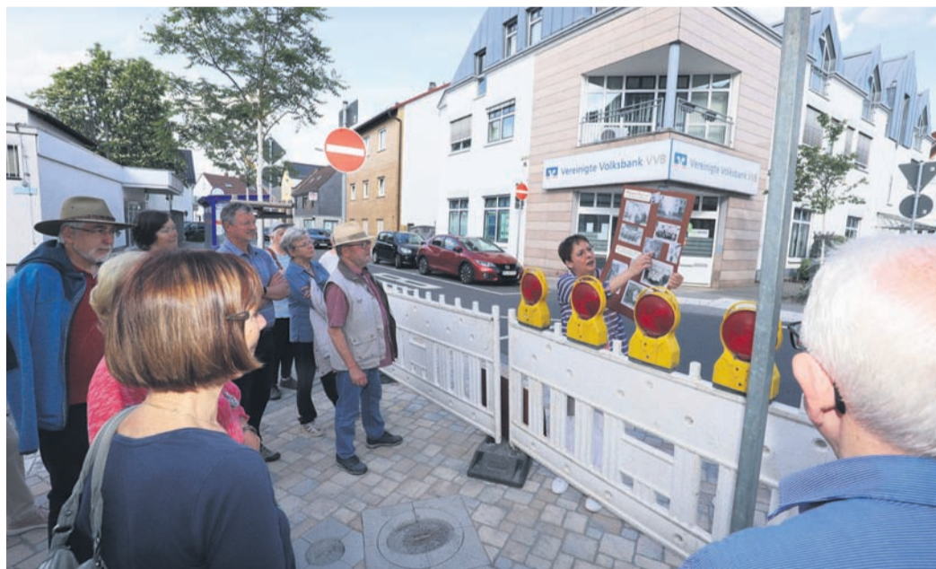
Von der Baustelle in der Bachgasse blickte die Gruppe hinüber zum ehemaligen Hanauer Hof, wo heute die Volksbank-Filiale steht. (Foto: PS)
