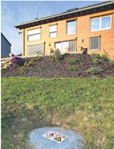
Diskrete Versorgung: Flüssiggas kann in erdgedeckten Behältern außerhalb des Hauses lagern.
