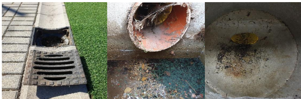
Abbildung 13: Niederschlagsablauf mit Sedimentationsbecken (links, Mitte) und ohne (rechts)
