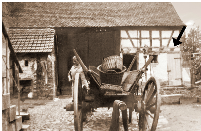
Abb. 2: Abort im Scheunengebäude Wixhäuser Straße 17. Rechts mit geschlossener Tür und Fenster der Abort, daneben mit offener Tür der Schweinestall. Davor Jauchepumpe und Mistkaute. Aufn. um 1950.
