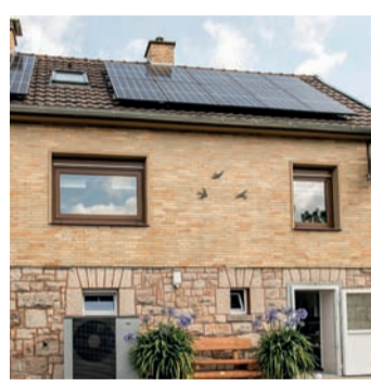
Mit einer Photovoltaik-Anlage selbst erzeugter Strom schafft Unabhängigkeit von steigenden Energiepreisen – NIBE PV-Smart macht die Nutzung in Verbindung mit einer NIBE Wärmepumpe besonders intelligent. Foto: NIBE Systemtechnik
