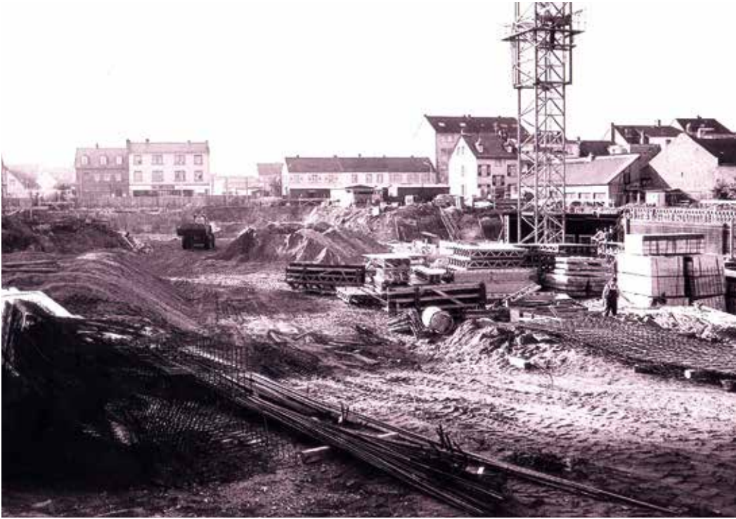
Bau der Hugenottenhalle im Oktober 1975.
