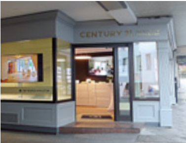
Einladend und hell gestaltet – die neue Fassade von André Immobilien und CENTURY 21.
