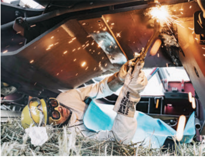
Das Schweißgerät kommt zum Einsatz beim THW.
