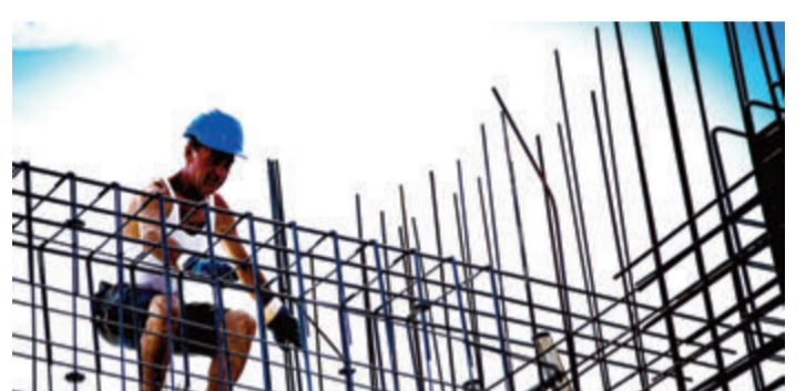
Ein Stahlflechter bei der Arbeit.
