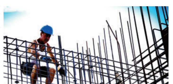
Ein Stahlflechter bei der Arbeit. Foto: IG Bau
