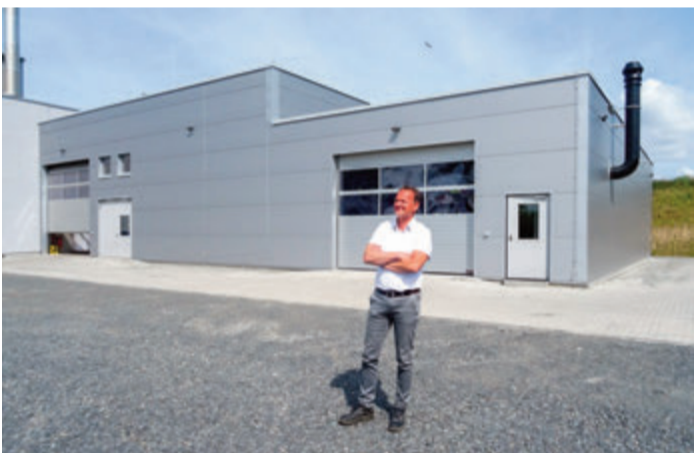
Ein Blick von außen auf die Produktionsanlage.
