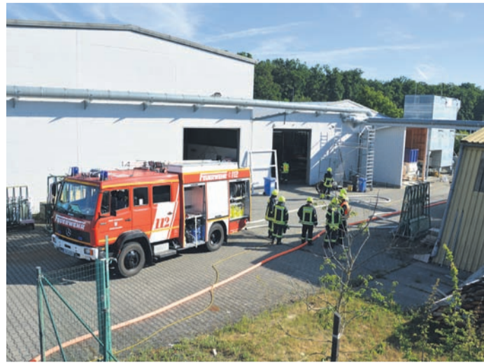
Die Feuerwehr vor Ort im Eppertshausener Gewerbegebiet Ost.
