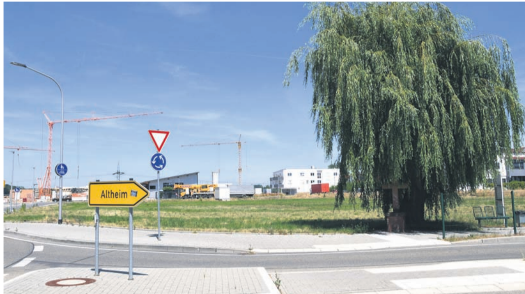
Auf diesem Grundstück mit dem Feldkreuz (vorn rechts) sollen der Netto-Markt und die 22 Wohnungen entstehen. Der Kran hinten links steht auf der Baustelle der G&P-Gruppe. (Fotos: jedö)
