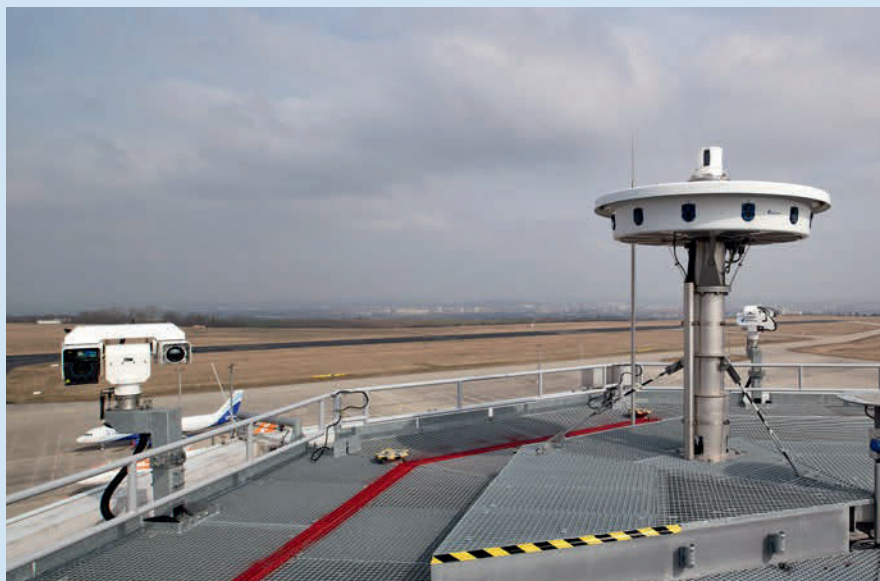
Remote-Tower-Control-Technologie am Flughafen Erfurt. Foto: DFS
