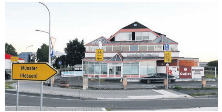
Das Gelände mit der einstigen Kultdisco „Tropical“ wartet auch fünfeneinhalb Jahre nach dem Kauf durch einen Investor auf seine Entwicklung und gibt am östlichen Ortseingang von Münster eine schlechte Visitenkarte ab. (Foto: jedö)
