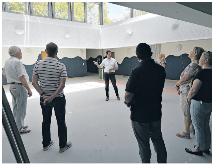
Bürgermeister Jan Fischer (Mitte) besichtigt mit Mitgliedern des Gemeindevorstands sowie der Verwaltung die Baustelle in der Kita Ochsengrund. Foto: Gemeinde Nauheim
