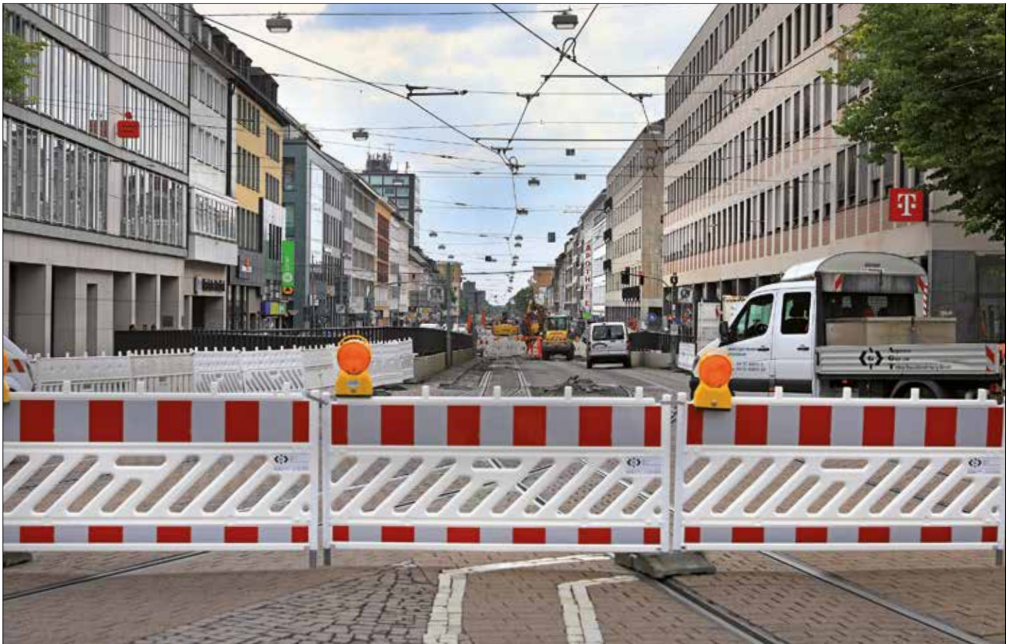
Baustellen, die Umwege erfordern, gibt es im Moment viele in Darmstadt.
