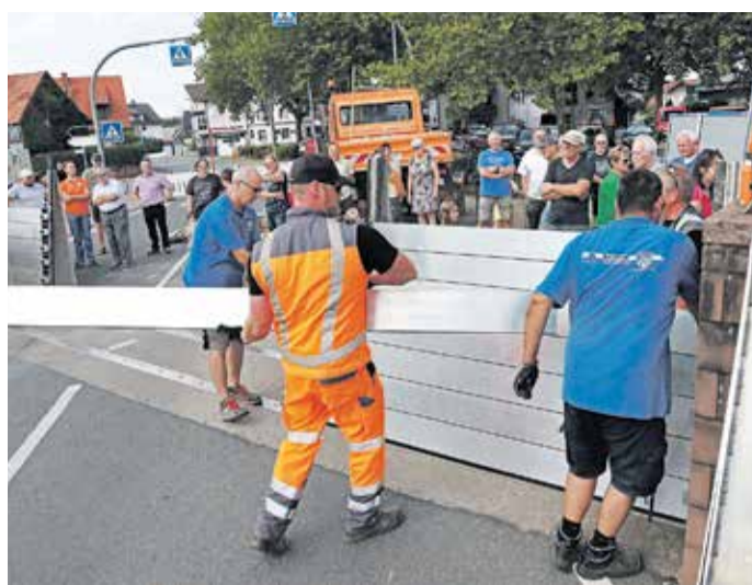
Bauhofmitarbeiter demonstrieren den Aufbau des Rheintors. Foto: Stadt Riedstadt
