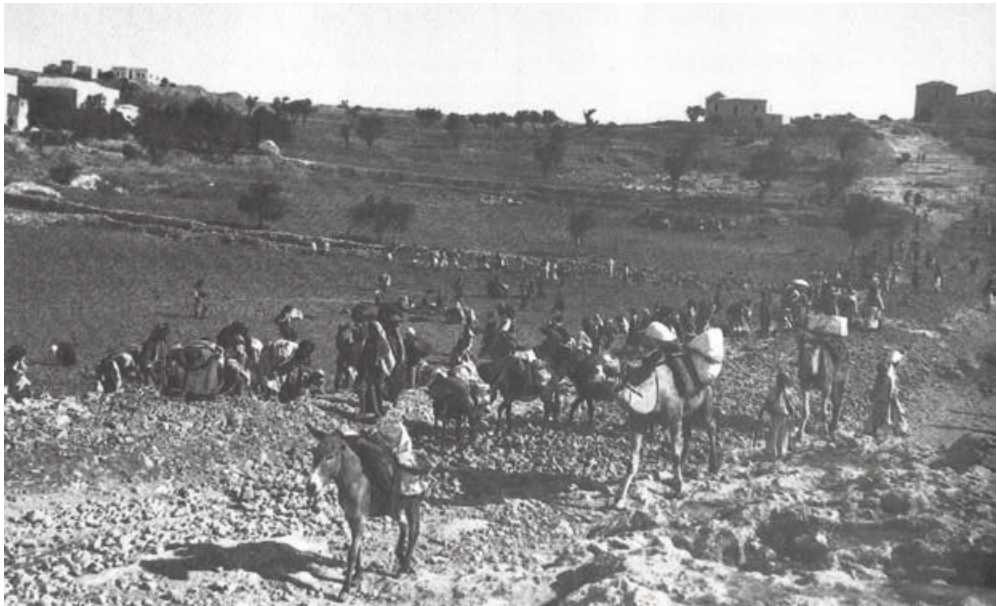
Abb. 17: Straßenbaumaßnahmen an der Jerusalemstraße 641
