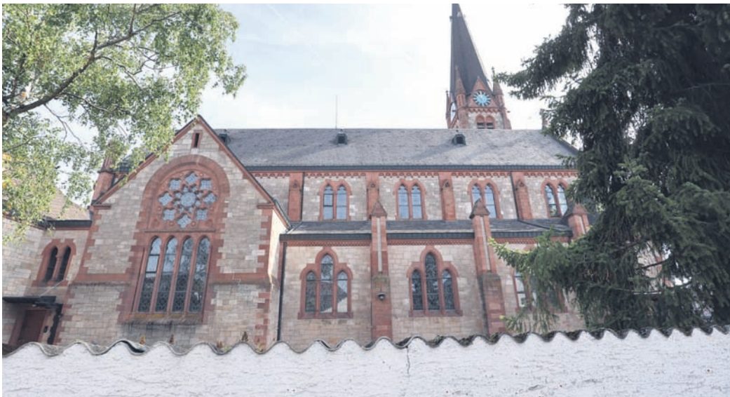
Bei der Verwirklichung des Projektes würde die Mauer am Fußweg zwischen der Heitkämperstraße und der Pfarrgasse abgerissen. (Foto: PS)
