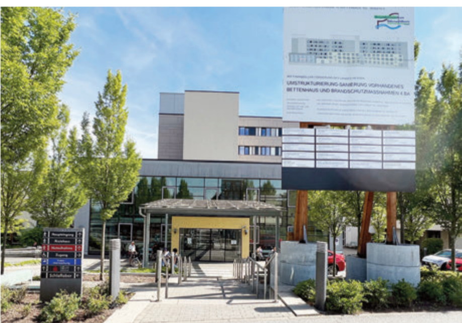
Die Möglichkeit besteht, dass coronapositiv getestete Mitarbeiter weiterarbeiten; dann aber nach Bedarfsprüfung und unter Auflagen. Foto: Clarissa Yigit
