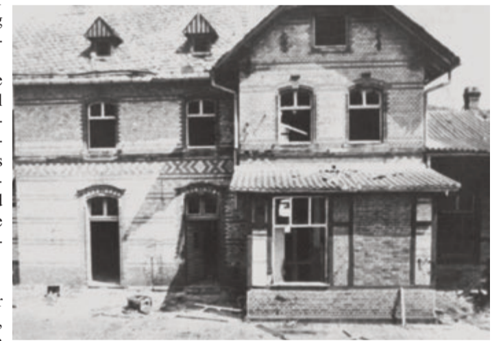
Der verfallende Bahnhofsgelände kurz vor seinem Abriss 1976 Foto: Bildarchiv Kerbverein
