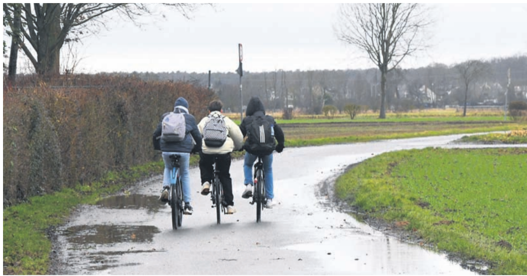
Der Rad- und Fußweg zwischen Münster und Eppertshausen wird unter anderem von vielen Eppertshäuser Kindern genutzt, die zur Aue-Schule radeln. Der Eppertshäuser Teil des Wegs wird nächstes Jahr erneuert, was umstritten ist. (Foto: jedö)
