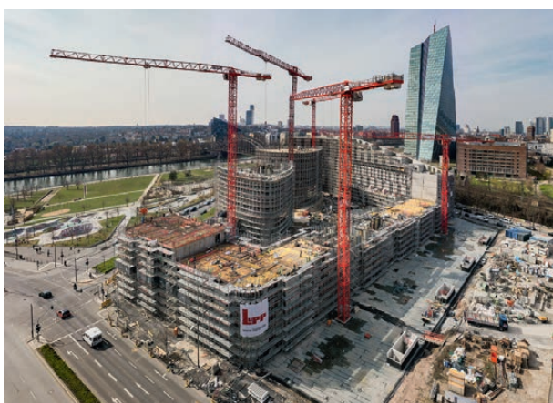
Die Dimensionen der heutigen Großbaustellen wie hier in Frankfurt lassen sich nur per Luftaufnahme erahnen.
