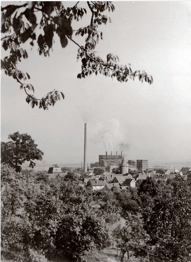
PreussenElektra Kraftwerk und Bergbau Wölfersheim: Gesamtansicht des Braunkohlen-Schwelkraftwerks im Jahr 1953
