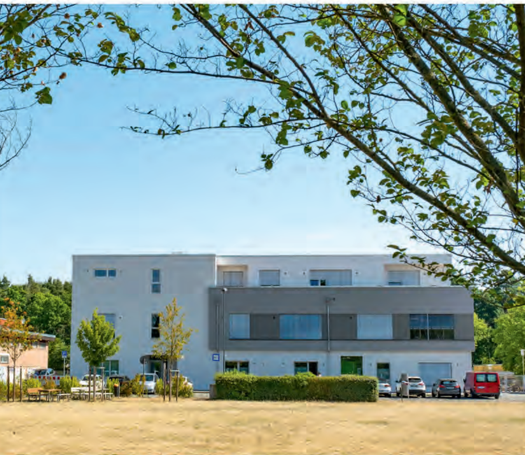
Klimafreundlich und energiebewusst: Die Dächer der Gebäude am Dreiherrnsteinplatz 4 und 9 sind mit PV-Anlagen ausgestattet worden.
