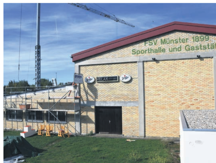
Ein Foto aus dem Oktober, als die FSV Münster die Erneuerung ihres Dachs abschloss. Ein neuer Hallenboden für zusätzliche Sportangebote und eine große Rasenplatz-Erneuerung sollen noch folgen. (Foto: jedö)
