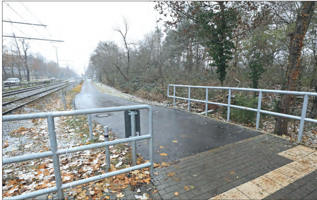
Entlang der Heidelberger Straße wird ein Zaun installiert.
