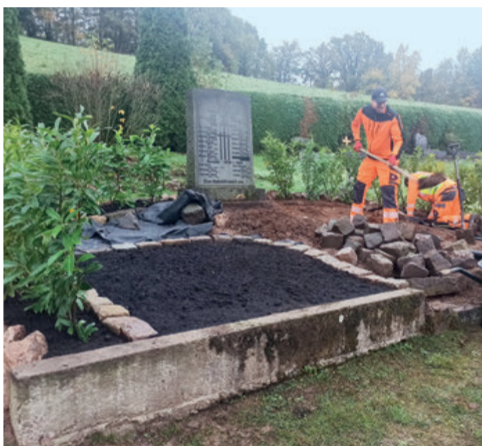
Die städtischen Bauhofmitarbeiter haben im Laufe des Jahres die Fläche um das Mahnmal der Gefallenen auf dem Friedhof in Ebersberg neu gestaltet. Foto: Bauhof Erbach
