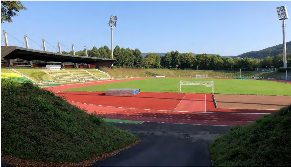
Ansicht 41: Stadion Baunatal; Aufnahme vom 21. August 2019
