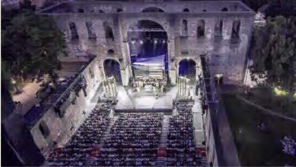
Ansicht 122: Burgruine Bad Hersfeld, Quelle: Stadt Bad Hersfeld
