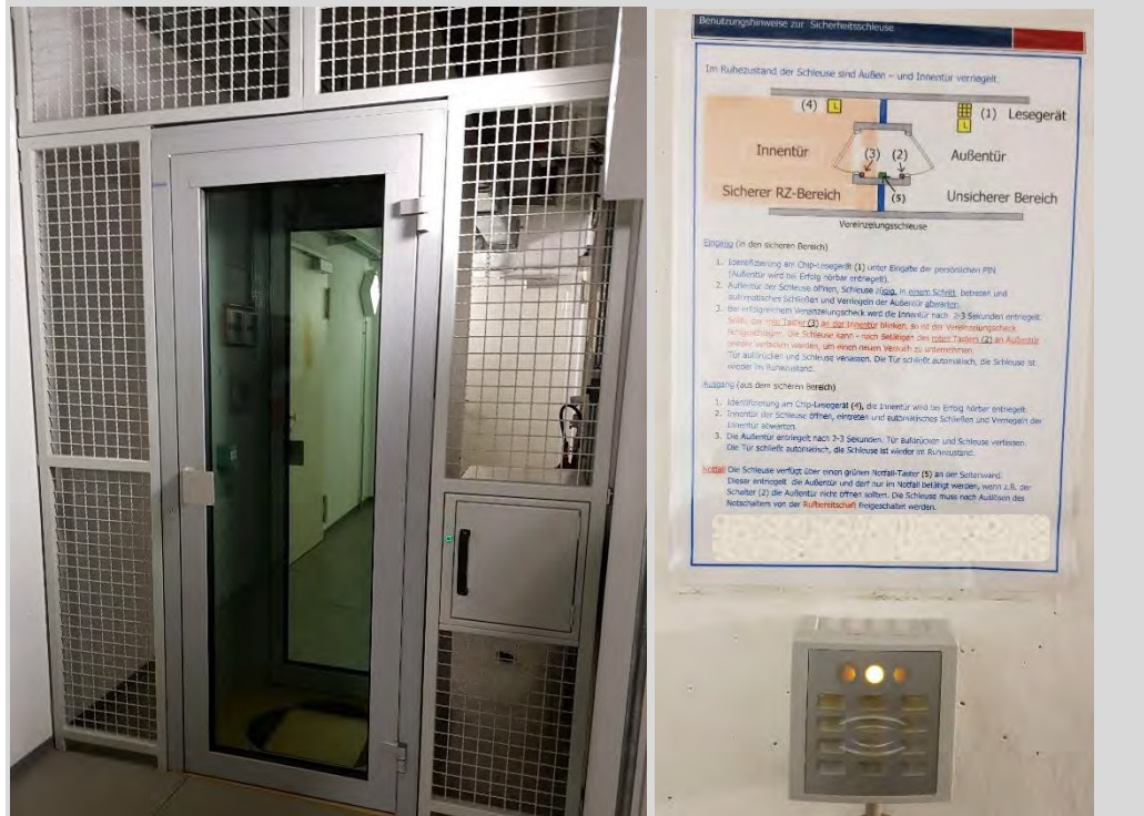
Ansicht 99: Vereinzelungsschleuse und zugehörige Anleitung im Kellergeschoss des Neubaus am Standort Kassel (Aufnahme vom 21. Februar 2019)
