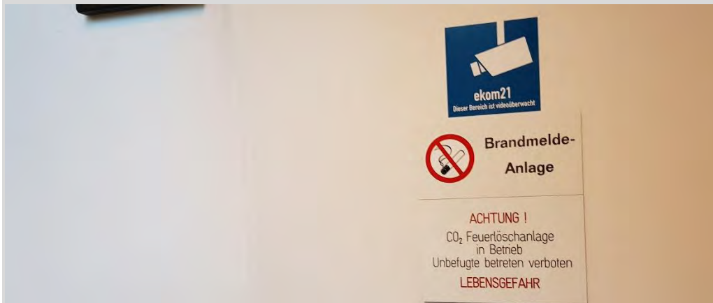
Ansicht 98: Tür zum Kellergeschoss am Standort Kassel (Aufnahme vom 21. Februar 2019)
