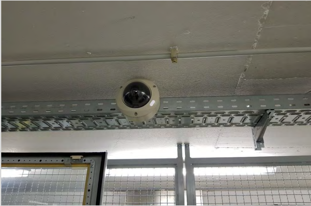
Ansicht 97: Kameraüberwachung des Serverraums im Kellergeschoss des Standorts Gießen (Aufnahme vom 12. Februar 2019)
