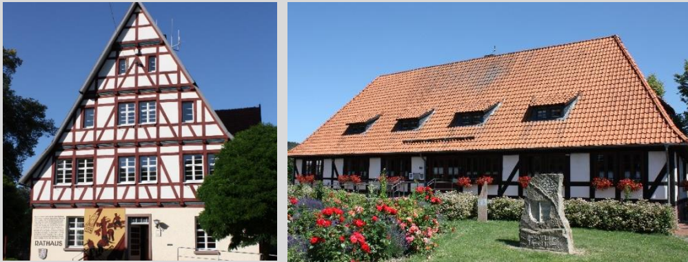
Ansicht 96: Rathäuser von Oberweser (links) und Wahlsburg (rechts) (Quelle: Gemeinden Oberweser und Wahlsburg)
