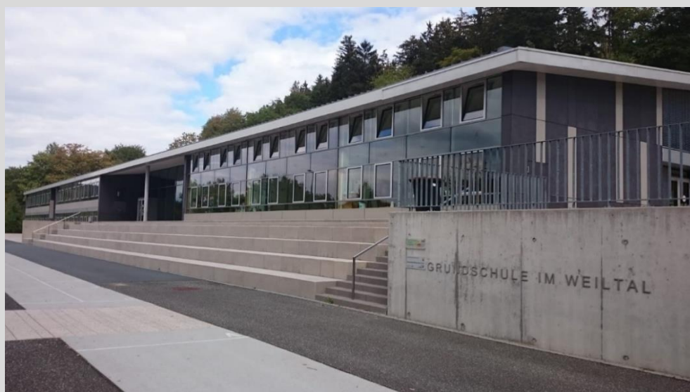
Ansicht 27: Grundschule im Weital, Aufnahme vom 18. Juni 2019
