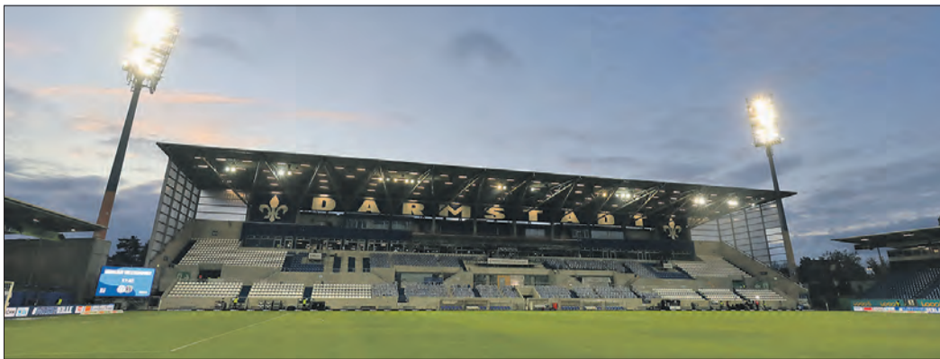
LOS GEHTS VOR VOR DER NEUEN HAUPTTRIBÜNE.
