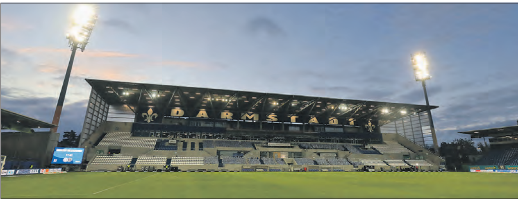
LOS GEHTS VOR VOR DER NEUEN HAUPTTRIBÜNE.
