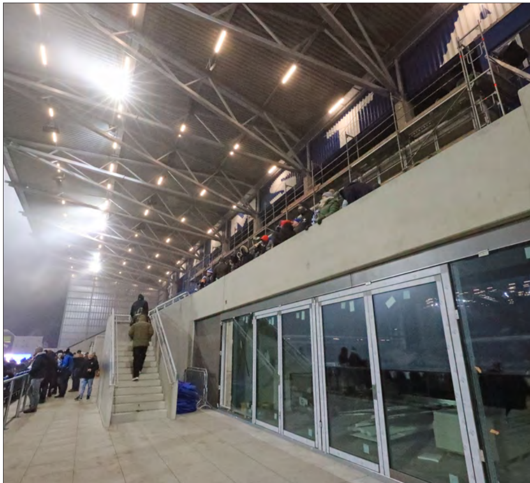
VORSICHT BAUSTELLE: Einige Bereiche der neuen Haupttribüne werden zum Start der Rückrunde noch nicht fertiggestellt sein. (Foto: Arthur Schönbein)
