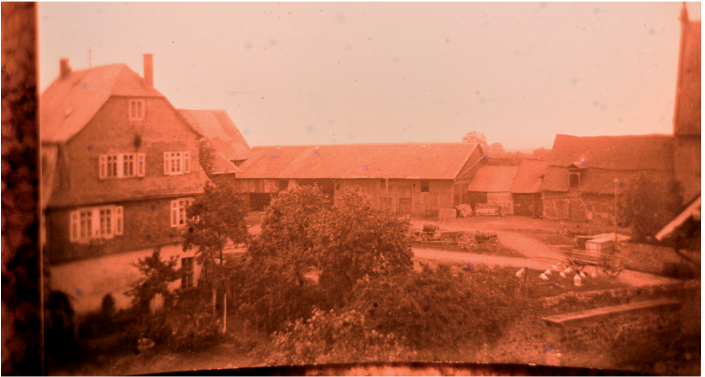
Die Stadtmauer am ehemaligen Posthof zwischen Museum (links) und dem Solmsers Schloss wurde im Frühsommer 1945 von den Amerikanern gesprengt. Rechts unter der Posthofscheune verbergen sich die Fundamente des Viereckturmes am Solmsers Schloss.
