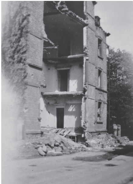
Das Anwesen der Bismarckstraße 10 nach einem Bombentreffer am 27.12.1944. Die Bismarckstraße war einst die vornehmste Straße in Butzbach. Dort durften keine Pferdefuhrwerke durchfahren.
