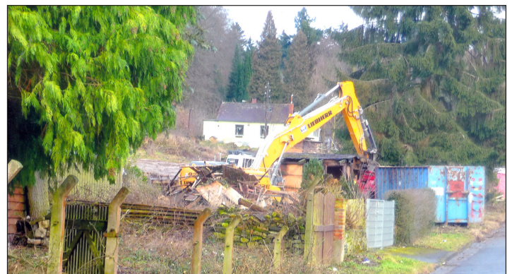
Der Abriss der Munihäuschen im Februar 2016 mit Blick auf das ehemalige Wirtshaus der weithin unter dem Namen „Black Mary“ bekannten tüchtigen Wirtin Foto: Erika Gillmann
