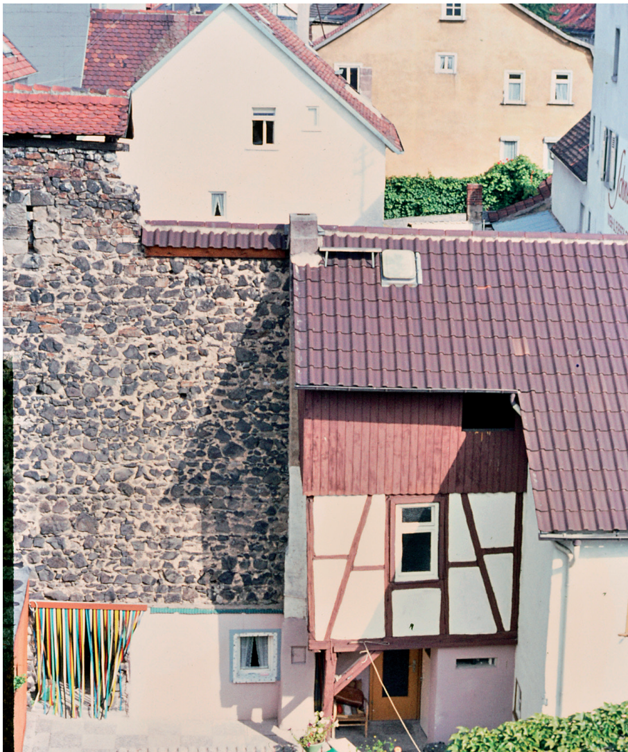
Blick von der Bismarckstraße auf die Südseite des Schwibbogenhäuschens Amtsgasse Nr. 13, heute: PENSION „Im Stadtmäuerchen“
