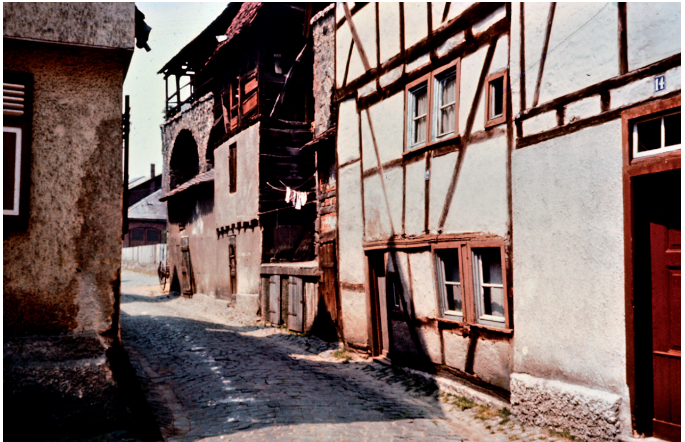
Blick vom Hexenplatz in die Krachbaumgasse. Im Vordergrund das „Henkershäuschen“, Krachbaumgasse 12. Hauseigentümer war der Armenfonds Butzbach.
