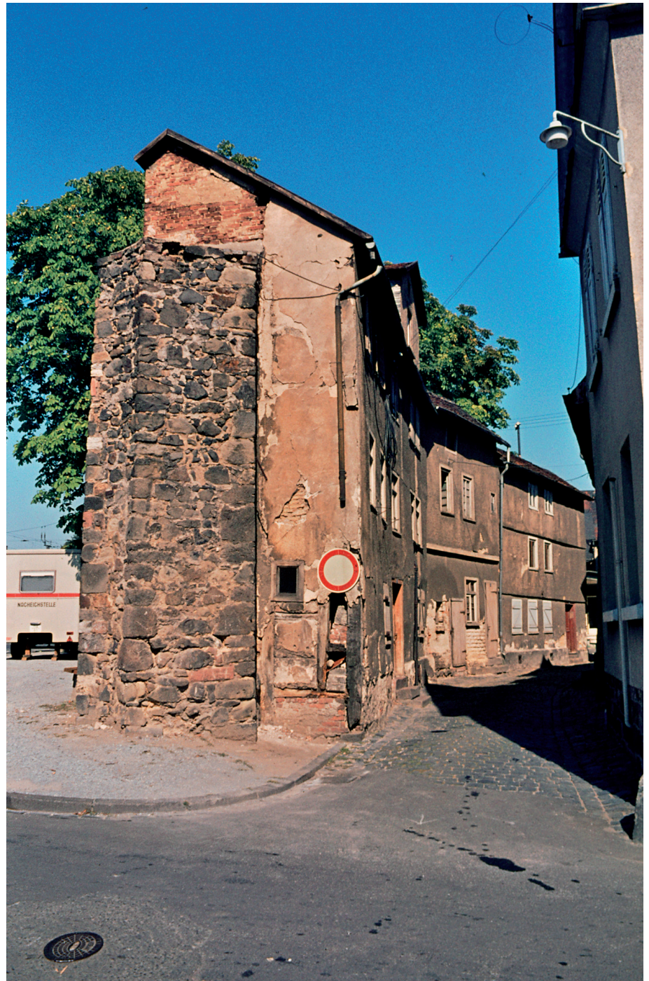
Schwibbogenhäuser neueren Typs zwischen Rossbrunnenstraße und Guldengasse mit Mauerfenstern und umfangreichen Maueraushöhlungen zwecks Wohnraumgewinns.
