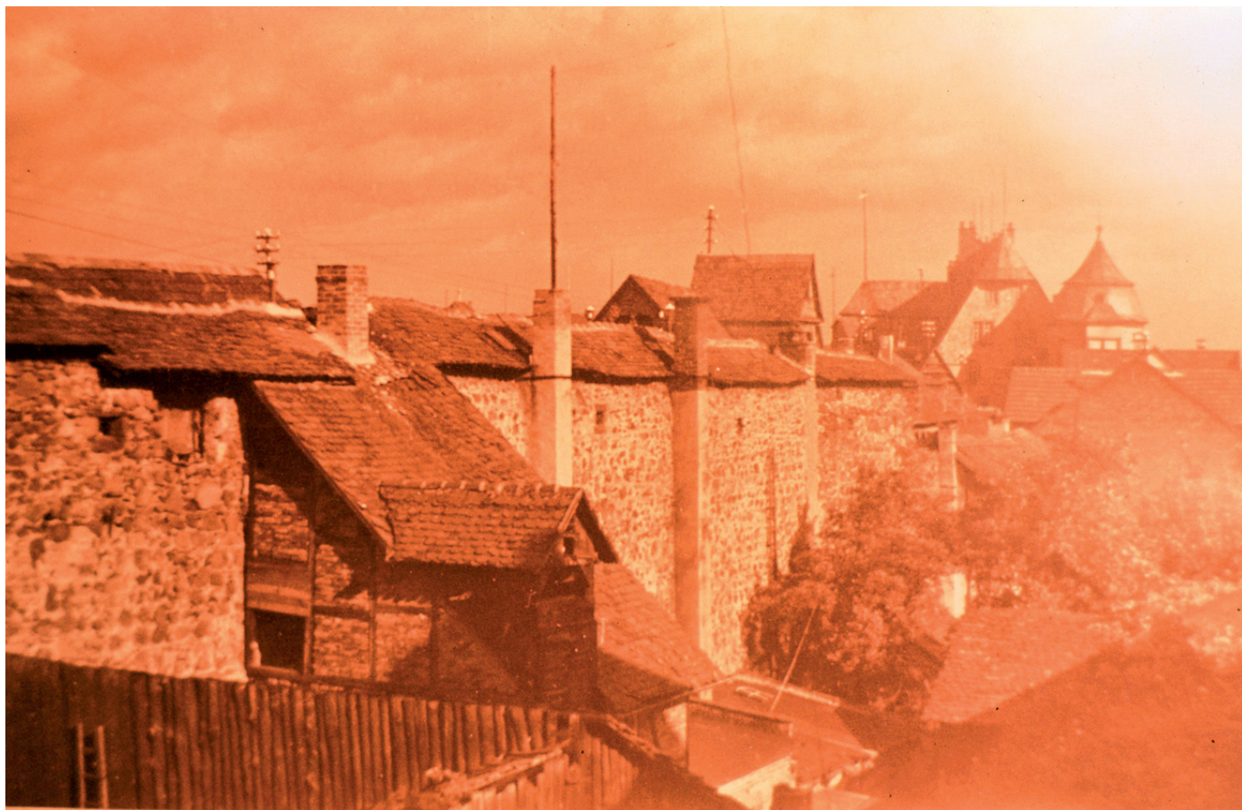
Blick von der Bismarckstraße auf die Südseite der Stadtmauer an der Amtsgasse, am 27.12.1944 durch Bombenangriff weitgehend zerstört.
