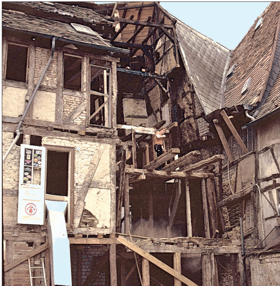
Unter den Häusern Wetzlarer Str. 11, 13 und 15 lag der Abschnittsgraben, der in fränkischer und karolingischer Zeit offen war. Das Bild entstand während der Sanierungsarbeiten.
