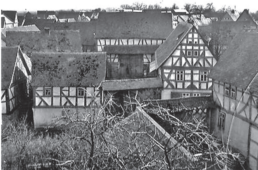
Gesamtanlage Kirch-Göns Anfang 20. Jahrhundert
