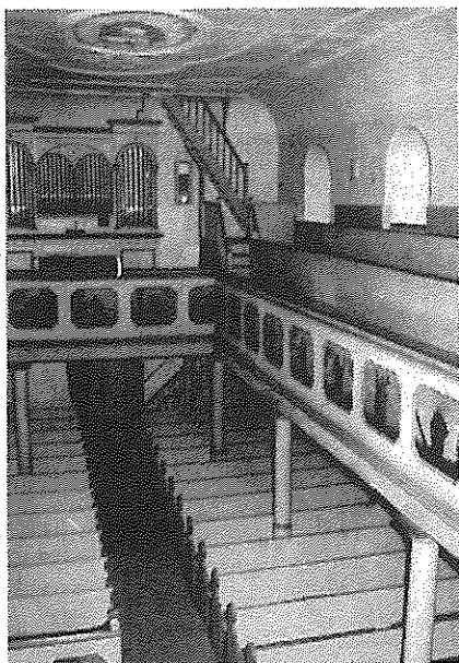
Blick in das Kirchenschiff mit den „Wibslautständern“, im Hintergrund unter der Orgelbühne der Aufgang zur Männerbühne (rechts) und zum Glockenturm, — alles ist aus Holz. An den Emporen die Brüstungsmalereien auf Tafelbildern.
