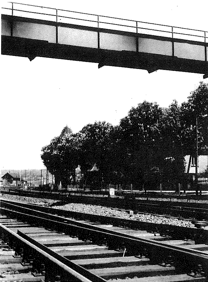
■ Blick über den Schienenweg in nördlicher Richtung. Im Hintergrund das Bahnwärterhaus des Überganges „Wetzlarer Straße“.
