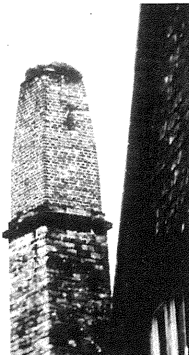
■ Schornstein der Griedeler Zuckerfabrik.
