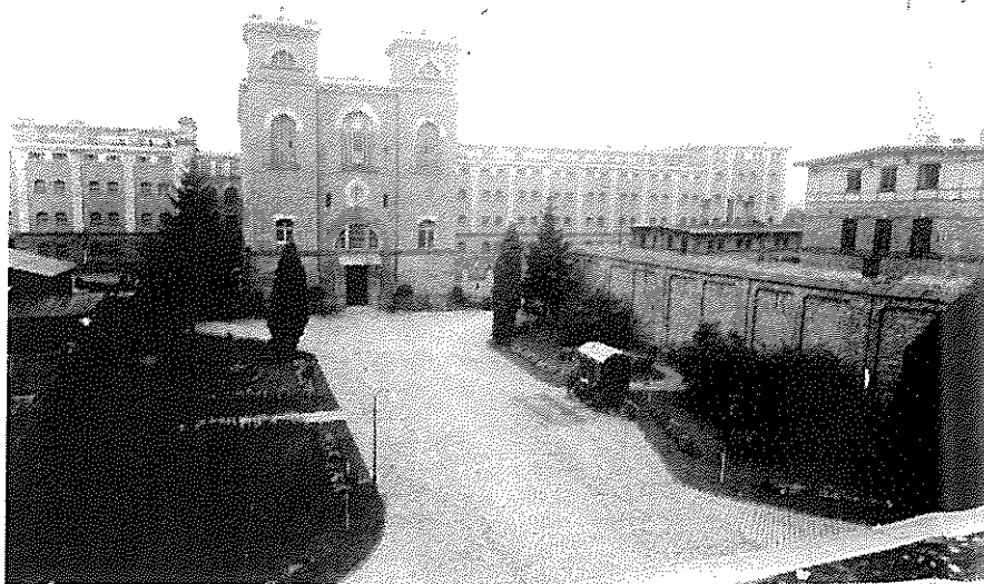
■ Blick auf den Innenhof der JVA.
