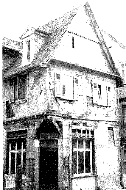
■ Kasernenstr. 11; unter dem Fundament des Hauses Brandschicht vom frühen 13. Jahrhun- dert.
