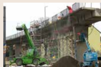
Rückbau der Cassellabrücke an der Hanauer Landstraße in Frankfurt
