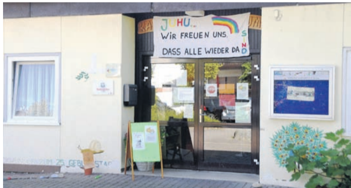
Wird abgerissen, erhält aber einen Neubau am jetzigen Standort: das Katholische Familienzentrum St. Michael mit seiner Kita an der Münsterer Gerhart-Hauptmann-Straße.
