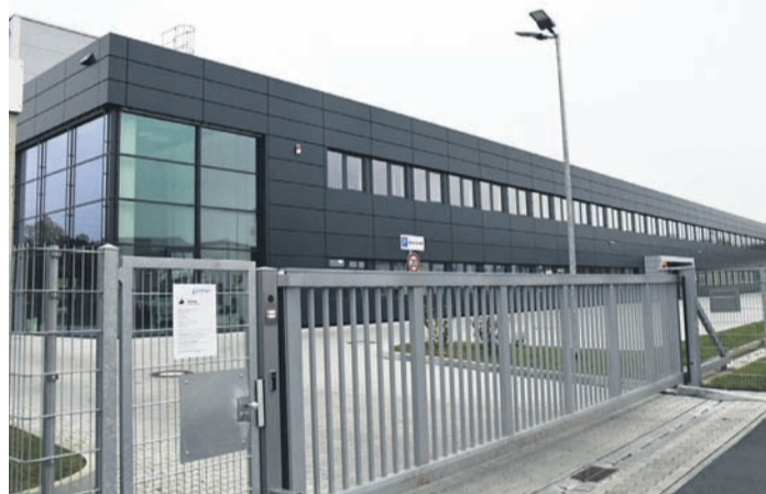
Inzwischen fertig sind Büros und Montagehalle von Günther Maschinenbau. Das Unternehmen zog von Dieburg in den Eppertshäuser „Park45“.
