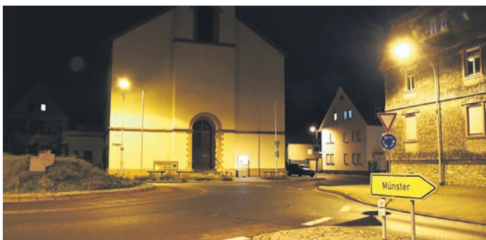
Die „Leistungsreduzierung“ der Eppertshäuser Straßenbeleuchtung - hier am Kreisel vor der Kirche St. Sebastian - soll in diesem Jahr 15 000 Euro einsparen. Viele andere Sparvorschläge bringen derzeit nur die berühmten „Peanuts“.
