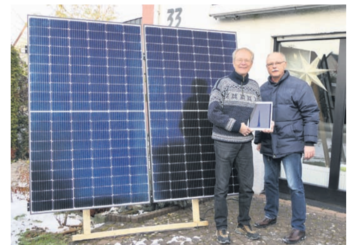
Nach der Testinstallation von zwei Steckersolar-Geräten auf der heimischen Terrasse freuen sich Wolfgang Hemmer-Girod (links) und Dierk Kallendorf über die Produktion des ersten Solarstroms. Im Frühjahr werden diese PV-Module dann zusammen mit den beiden Steckersolar-Geräten des Nachbarn auf den beiden Doppelhausdächern installiert. (Foto: privat)
