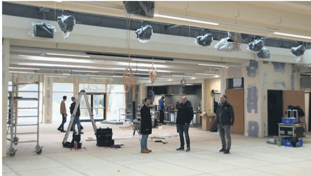
Soll nach den Osterferien in Betrieb gehen können: Blick über die Baustelle jenes Bereichs an der Münsterer Aue-Schule, der wahlweise als Mensa oder Aula dienen kann. (Fotos: jedö)
