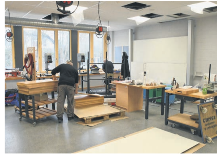
In jenem Trakt, der nach den Osterferien in Betrieb gehen soll, befinden sich auch mehrere neue Werkräume für die Schüler. Hier finden in einem davon letzte Arbeiten statt.
