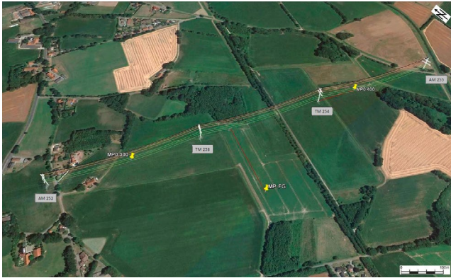
Bild 9: Ansicht des umgebauten Abspannabschnitts [8]
