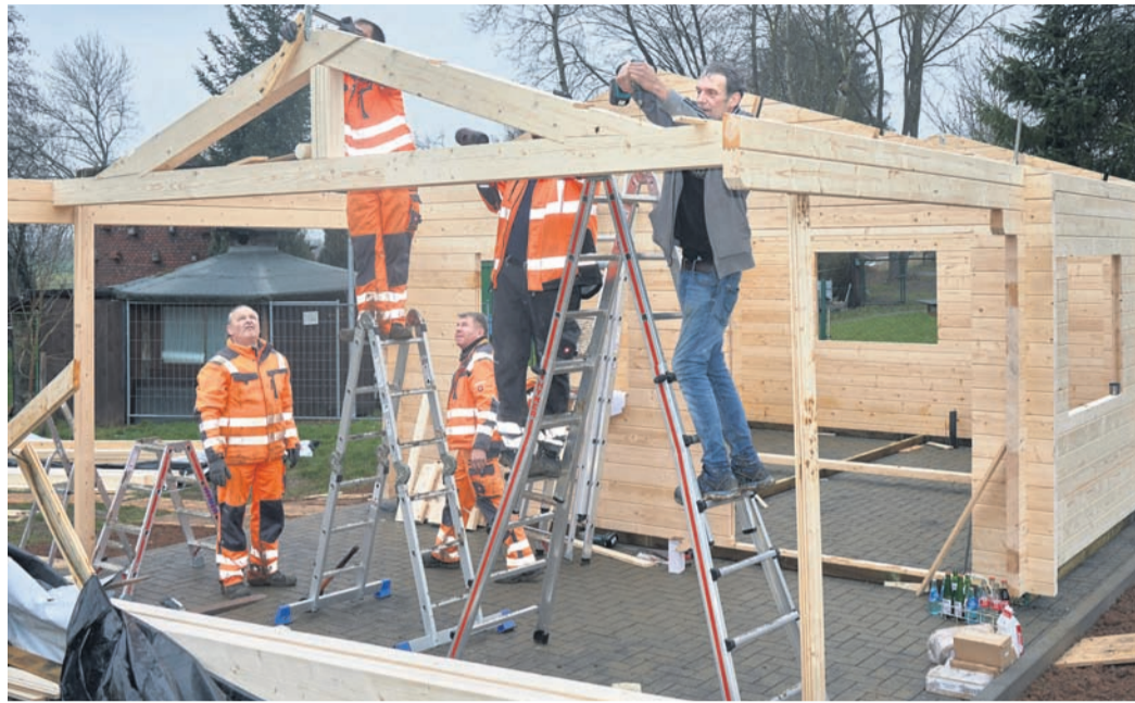
Ein Team vom Bauhof Neuberg und Dachdecker Jürgen Helle (rechts) beim Bau der Holzbohlenhütte für den Waldkindergarten der AWO Obertshausen. (Foto: AWO)
